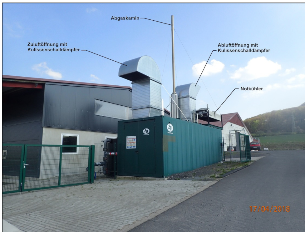
Abbildung 1: BHKW an der Hähnchenmastanlage
