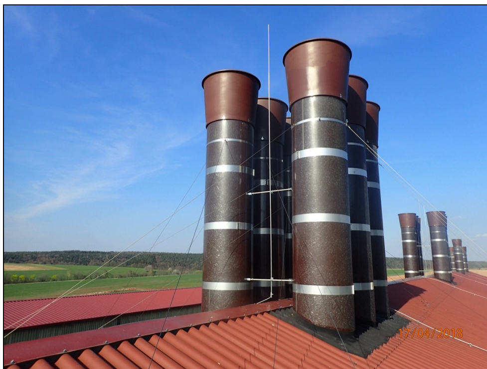
Abbildung 2: Abluftkamine Hähnchenmaststall
