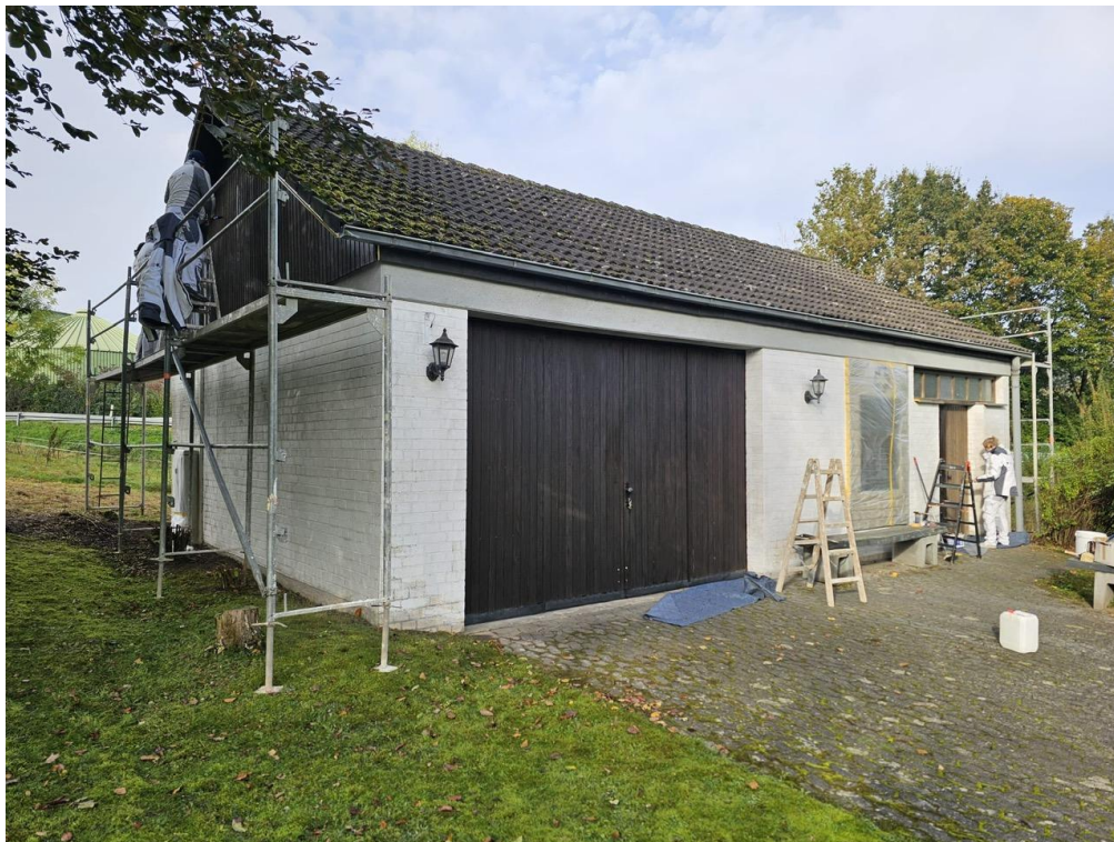
(Blick auf die Sanierungsarbeiten der Friedhofshalle Hillartshausen)
