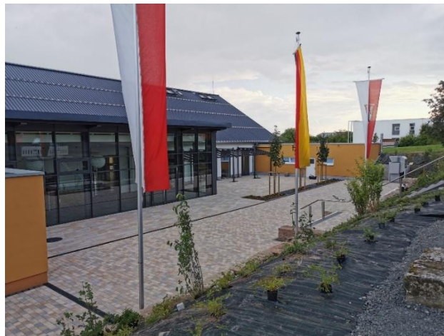
(Neuer Eingangsbereich der sanierten Festhalle Friedewald)
