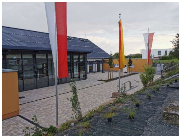
(Neuer Eingangsbereich der sanierten Festhalle Friedewald)
