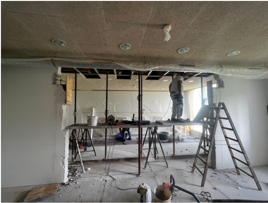
(Blick auf die Umbauarbeiten in der Kindertagesstätte „Schlosszwerge“)
