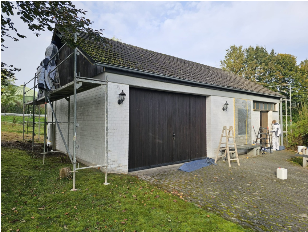
(Blick auf die Sanierungsarbeiten der Friedhofshalle Hillartshausen)
