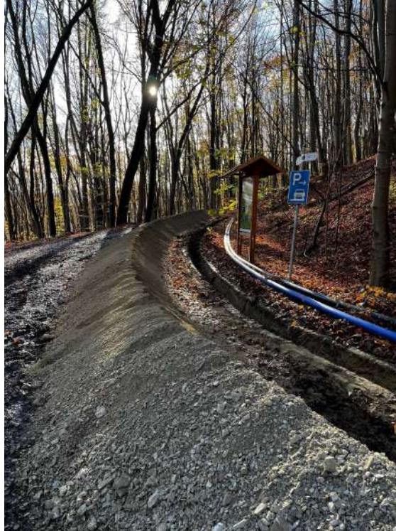
(Blick auf die Baumaßnahme Trinkwasserleitung Friedewald - Lautenhausen)
