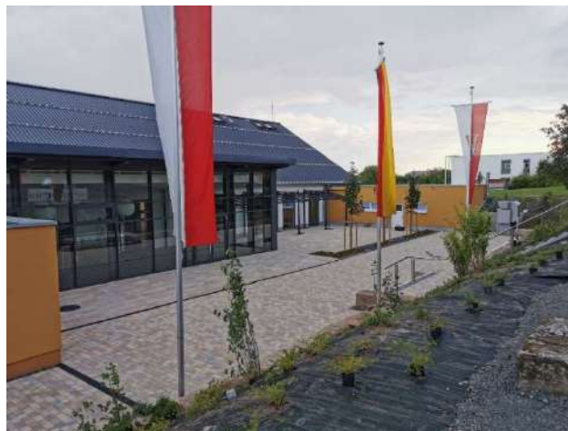
(Neuer Eingangsbereich der sanierten Festhalle Friedewald)
