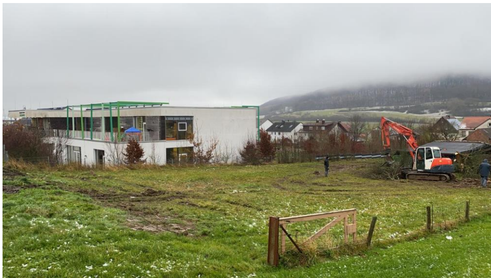
(Erste Arbeiten auf dem Baugrundstück der Kinderkrippe)
