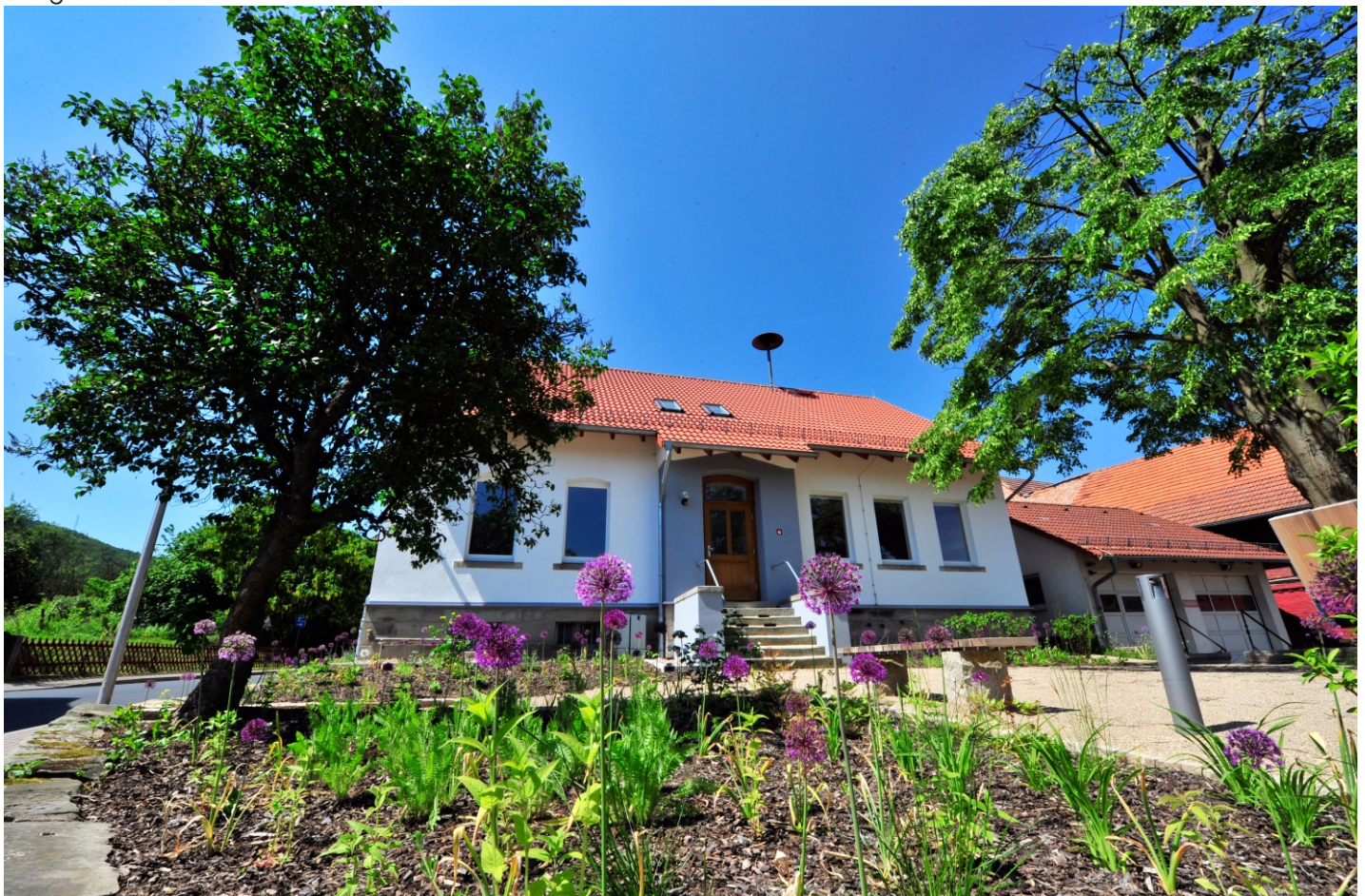
Dorfgemeinschaftshaus in Hillartshausen
