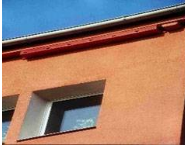
Abb. 2: Das Anbringen von Nistkästen kann heutzutage auch recht unauffällig erfolgen (Bildquelle: www.nabu-weimar.de/projekte/artenschutz/gebäudebrütterschutz )
