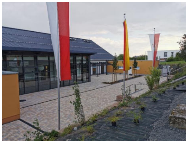
(Neuer Eingangsbereich der sanierten Festhalle Friedewald)
