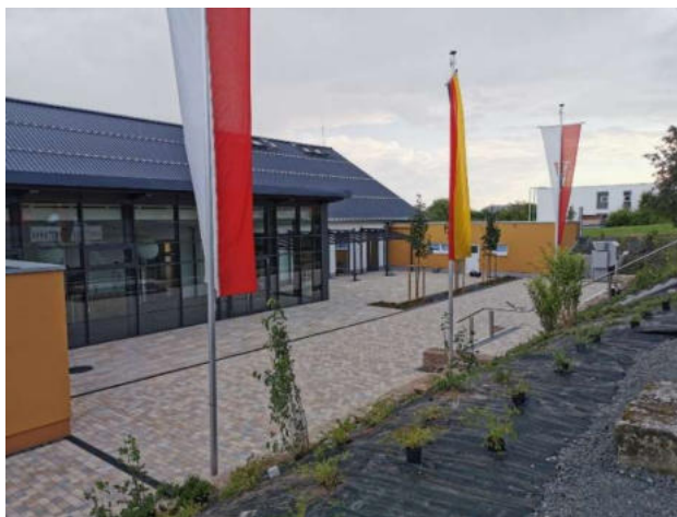
(Neuer Eingangsbereich der sanierten Festhalle Friedewald)
