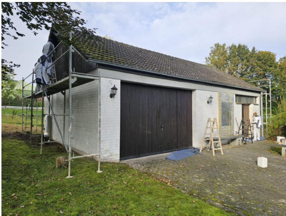
(Blick auf die Sanierungsarbeiten der Friedhofshalle Hillartshausen)
